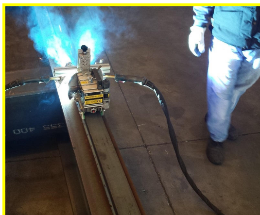
SALDATURA PIATTO SU TRAVE CON DUE TORCE
