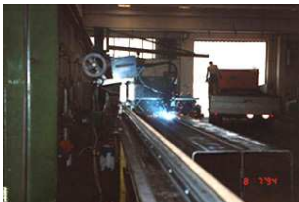
SALDATURA SCATOLATI BRACCI GRU'
